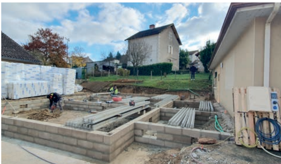
Travaux d'extension de la maison médicale à Bosmie-l'Aiguille
