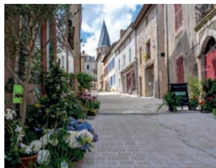
Réhabilitation des ruelles du centre-bourg à Rochechouart
