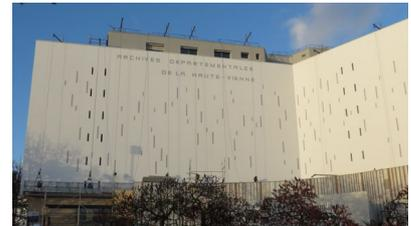
Ces travaux ont ainsi été l'occasion d'une **amélioration en profondeur des performances énergétiques** et des résistances aux chocs thermiques des bâtiments, par la mise en place d'un complexe isolant très performant en laine minérale sous les panneaux de façade et en cassettes métalliques.
