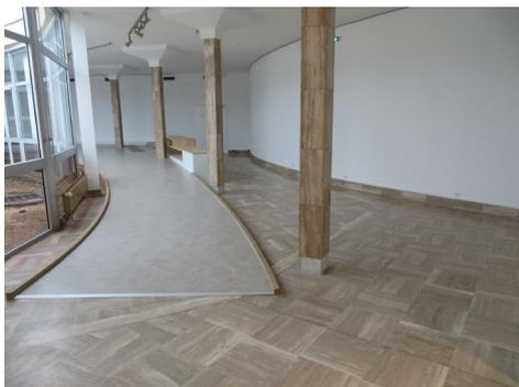
A l'intérieur, **les espaces d'accueil du public (accueil et salle de lecture) ont également fait l'objet d'une rénovation intégrale et d'une mise aux normes pour l'accessibilité** avec l'installation d'une plateforme élévatrice pour accéder à l'administration, d'une rampe pour permettre l'accès à la salle de lecture, et la création de sanitaires adaptés.
